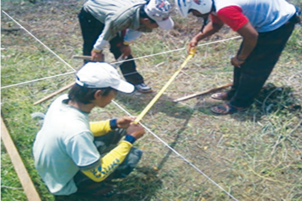
Gambar 6.1 Seorang tukang sedang mengukur kesikuan lahan
